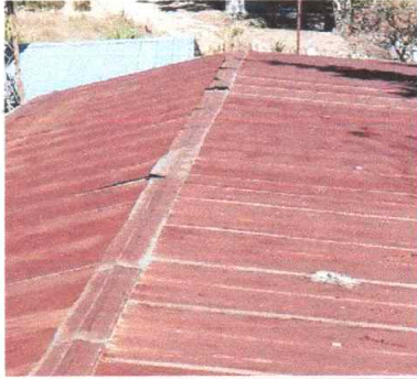
Foto 1: Sustitución de lámina galvanizada por lámina troquelada aluzinc del modulo N.1
