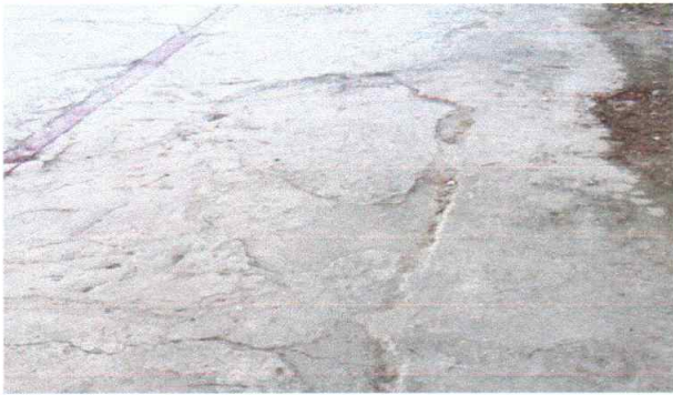
Foto 3: sustituciónn de piso de cemento a mosaico del aula N.1 del modulo N.1
